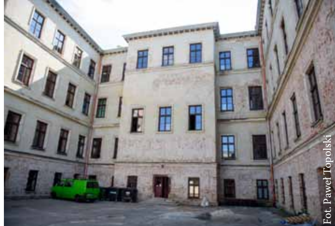
Najpoważniejsza pozycja w remontowych planach to renowacja zachodniej i północnej elewacji oraz elewacji wewnętrznych I Liceum Ogólnokształcącego.
